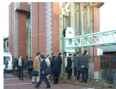
【瀬田川洗堰バイパス水路の見学】
