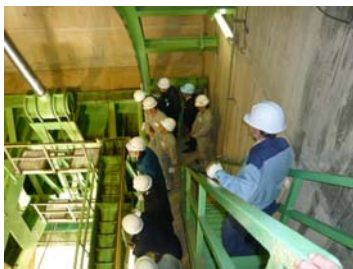
【常用洪水吐2号ゲートの動作確認の視察】
